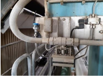
Kuva 1. Sensori kiinnitettynä paperikoneeseen.
